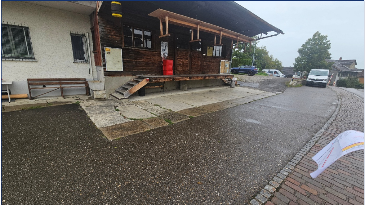
Abbildung 2: bestehende Bushaltestelle (NRP Ingenieure AG, 29.08.2025)
