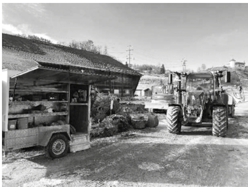
Neujahr 2024, die Baggerarbeiten im vollen Gang
