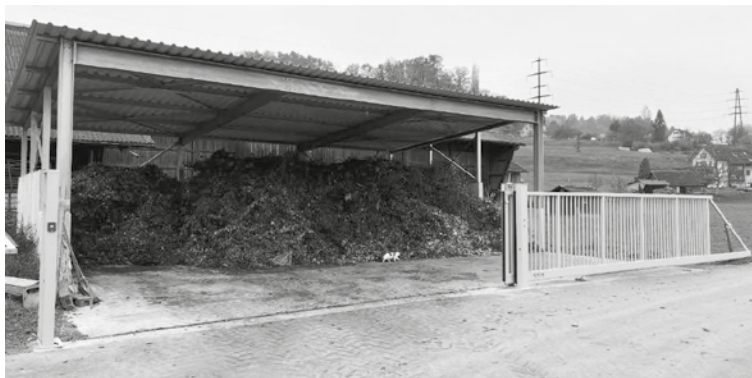
Der Platz nach Abschluss der Arbeiten
